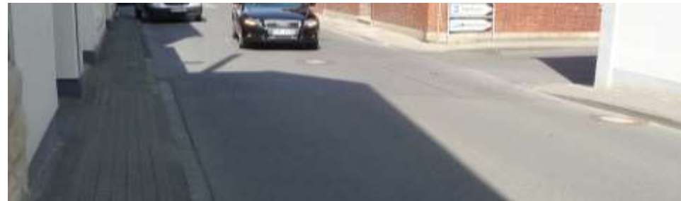
wenig Platz für Fußgänger (Ecksituation Kirchstraße/Kampstraße)
