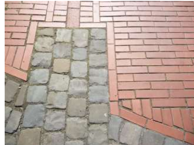
Übergänge zum historischen Pflaster
